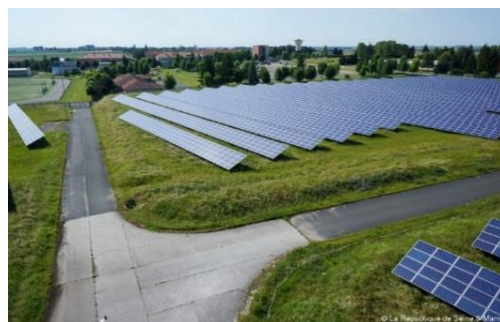
Panneaux photovoltaïques à la centrale de Sourduin mise en service en novembre 2011
