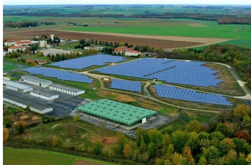
Centrale photovoltaïque à Sourduin
