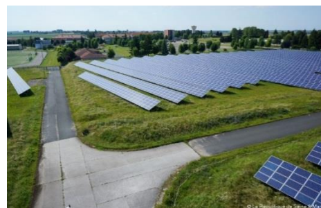
Panneaux photovoltaïques à la centrale de Sourdun mise en service en novembre 2011
