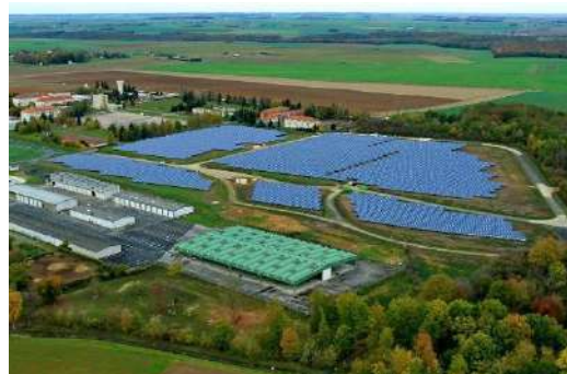
Centrale photovoltaïque à Sourdun
